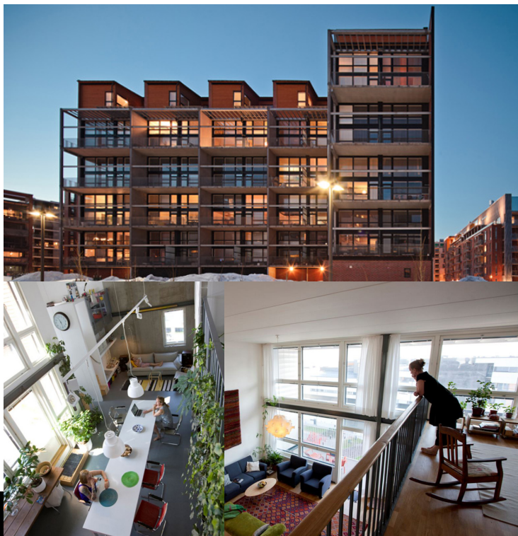
Exempel på flexibla lägenheter: Tila, Helsingfors. Arkitekt Pia Ilonen, Talli Arkitekter. En femvånings byggnad, stål och betong. 39 enheter, vardera 5m i takhöjd. Basytan varierar från 50m 2 till 100m 2 . Det är möjligt att bygga loft. Den enda enhet som är permanent är badrummet.
