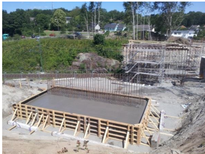
Figur 8 Gjutning av bottenplatta, brostöd 1
