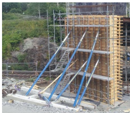
Figur 15 Stagning av form
