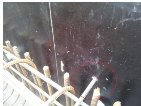
Figur 16 Armeringsstång som formstag genom täckskikt.
