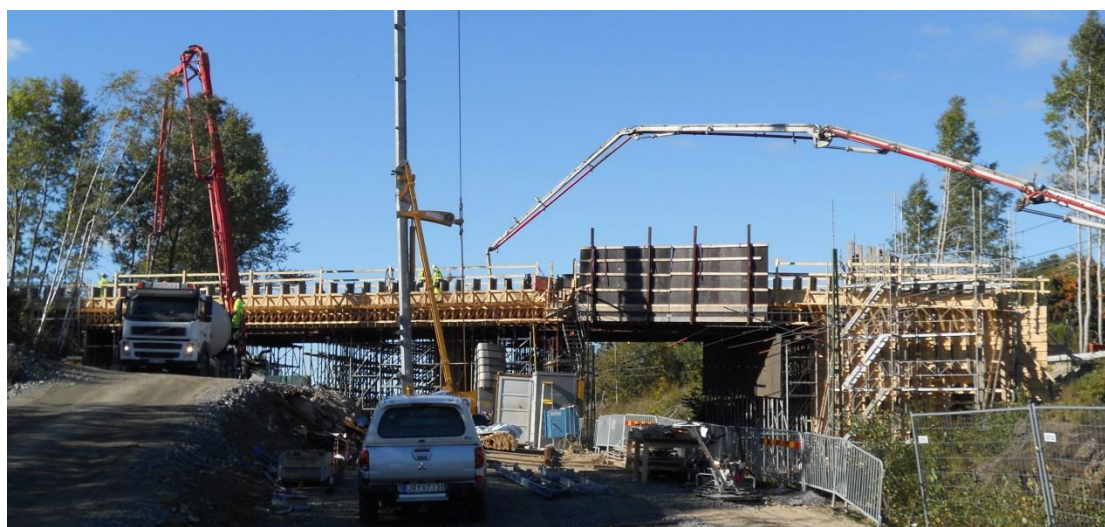
Figur 9 Gjutning av brostöden
