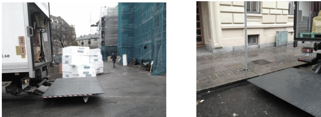
Fig. 5.2.3.1 Avlastningsplatserna a) Avlastning vid byggarbetsplats, b) Avlastning vid trottoarkant
