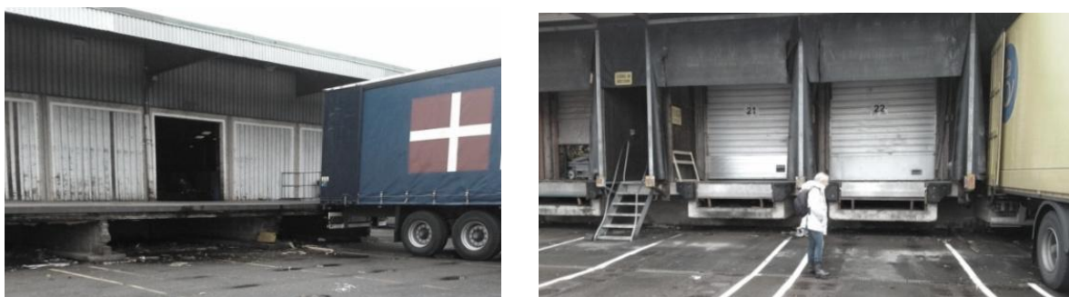
Fig. 5.2.2.1 a) Lastkaj, b) Sluss, Postens terminal i Göteborg
