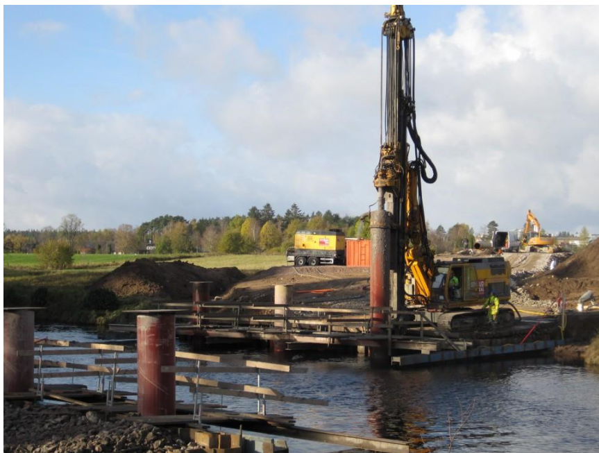
Figur 13: En borrhög installerar en stålrörspåle vid byggandet av bron utanför Ljungby (Styrud, 2013).
