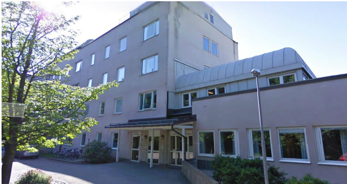
Figur 10: Byggnad 24 (Brändemo L, 2012a)
