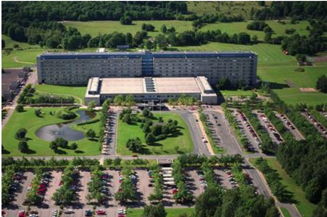
Figur 13: Översikt Kärnsjukhuset i Skövde (Västfastigheter, 2013)
