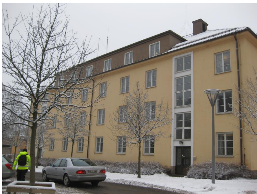
Figur 9: Byggnad 16 (Almström T, 2013)
