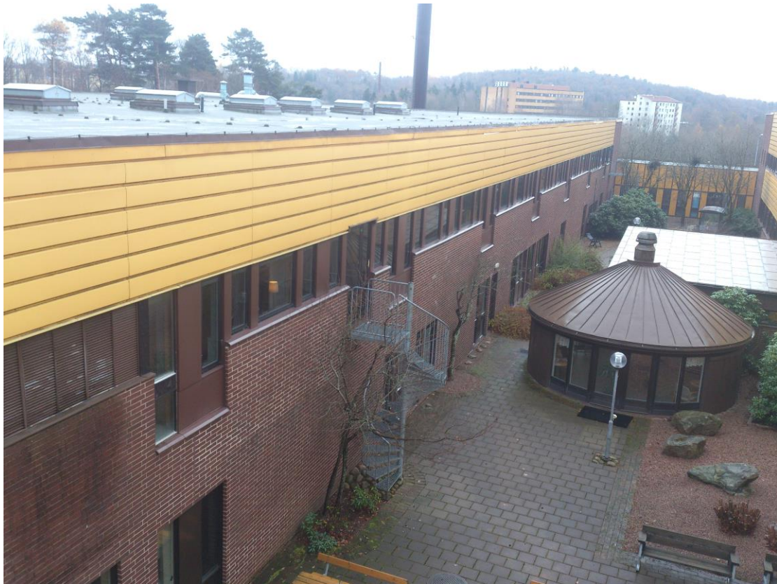
Figur 12: Byggnad 35 (Ottosson E, 2013b)
