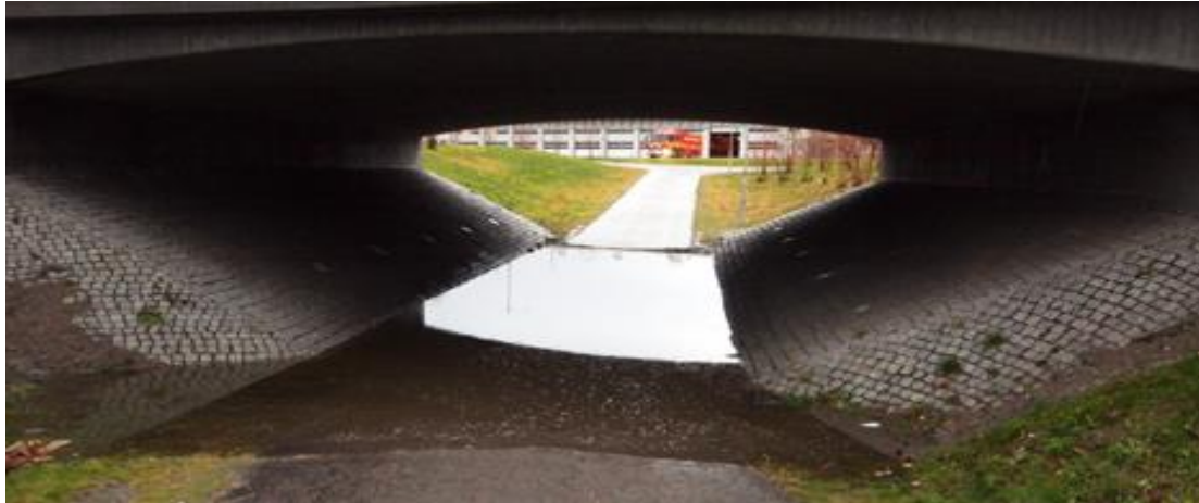
Picture 11 A plugged gully (Västerbottens- Kuriren, 2011).
