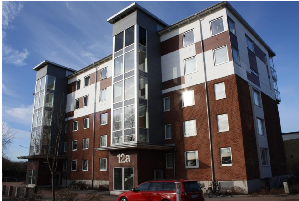
Figur 3: Kvarteret Vesslan etapp 1 våningspåbyggnad (Eget foto, 2013)
