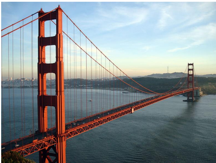
Figur 16: Bild på Golden gate bridge, en hängbro i stål från 1937. Vertikala linor lyfter upp brolasten till längsgående linor. De längsgående linorna hålls uppe av pyloner och förankras i betongfundament på båda sidor om bron (Niewiroski Jr, 2007).
