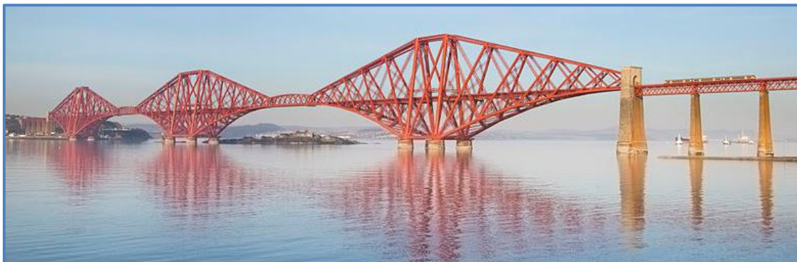
Figur 12: Bild på Forth Bridge i Skottland, en fackverksbro från 1800-talet. Fackverket bär brobanan med tryckta och dragna stänger och för lasten till stöden (Gastin, 2013).
