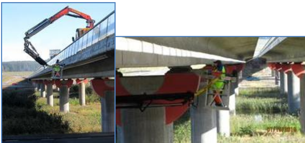
Figur 21: Bild på en inspektion med en "underbrolift", bron som inspekteras är en lådbalkbro i betong (Sundström, 2013).
