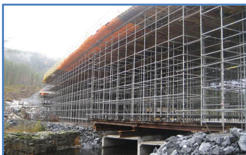
Figur 20: Figuren visar ett brobygge över ett litet vattendrag. Gjutformen hålls uppe av ställningen, ställningens uppgift är att bära formen och betongen tills betongen har härdat (Frico, 2013).
