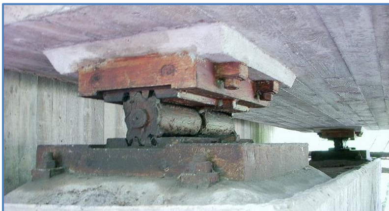
Figur 7: Bilden visar ett rulllager, ett ensidigt rörligt lager, som möjliggör rörelser i brons längsriktning (Ellgaard, 2010).
