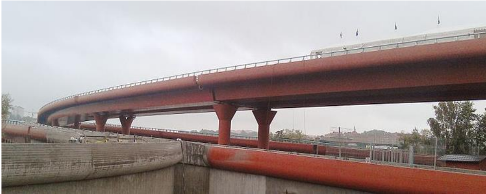
Figur 10: Bild på en lådbalkbro i stål i Partihallsförnildelsen. Lådbalken bär brobanan och för lasten till stöden (Luen, 2011).
