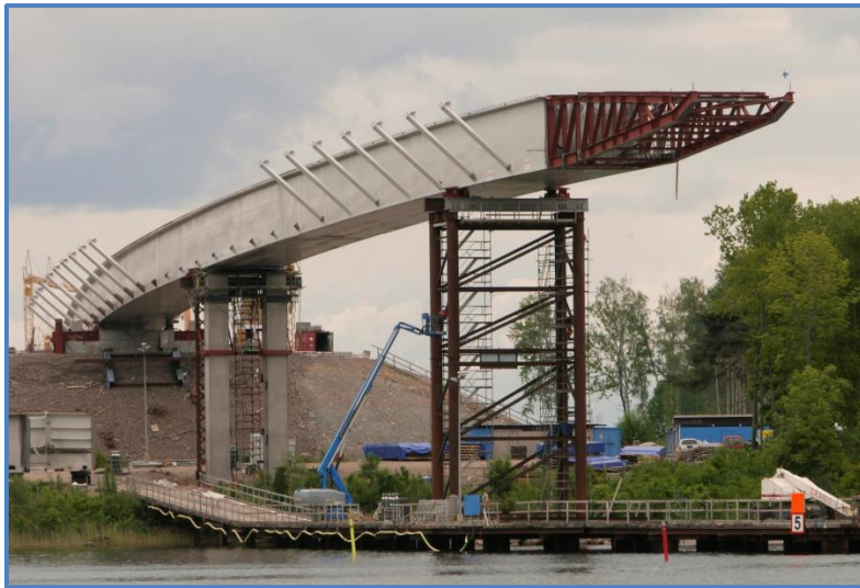
Figur 19: Bilden visar en pågående lansering av en stålbro över ett vattendrag i Motala. Närmast i bilden kan en röd lanseringsnos ses, den är utformad för att väga lite och snabbt ge bron en upplagspunkt på nästkommande stöd.
