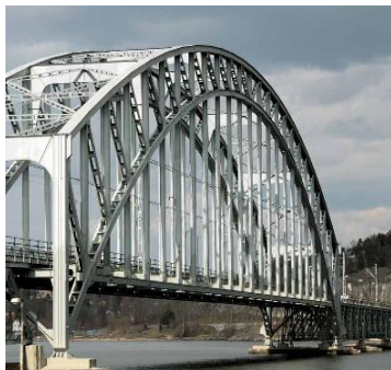
Figur 4-11. Fackverksbåge av stål med en spännvidd på 140 m (Stålbyggnadsinstitutet, 2013).
