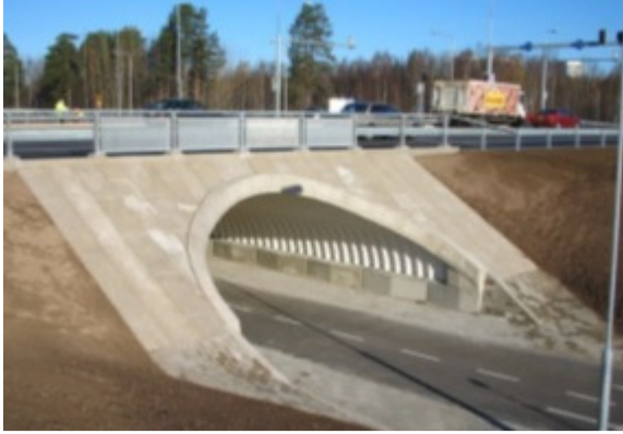
Figur 4-14. Kraftigare rörbro av stål med betongpåggjutning (Vägverket, 2008b).
