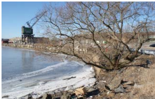
bild 22: vackert/fult - skräp längsmed vattenkanten och en rostig kran som håller på att förfalla
