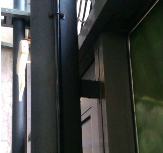
Figur 24: Exempel på glasfasad som är fäst i en invändig stålkonstruktion på Universeum
