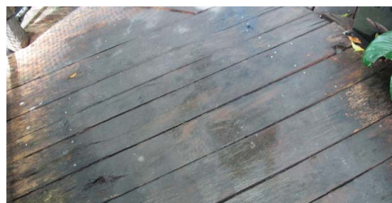
Figur 49: Trä kan bli halt när det är fuktigt
