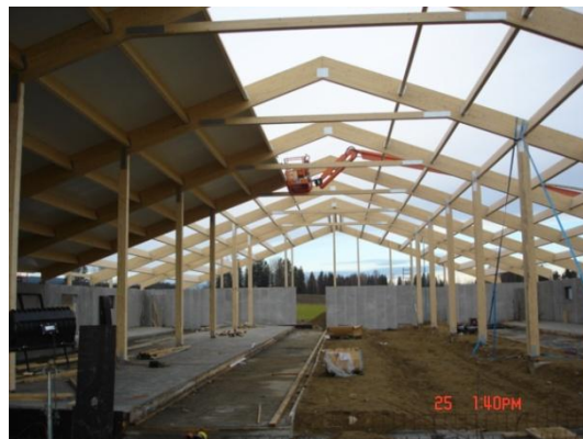
Bild 2.2 Takkonstruktion med takås, Se Bygg i limträ (2012).
