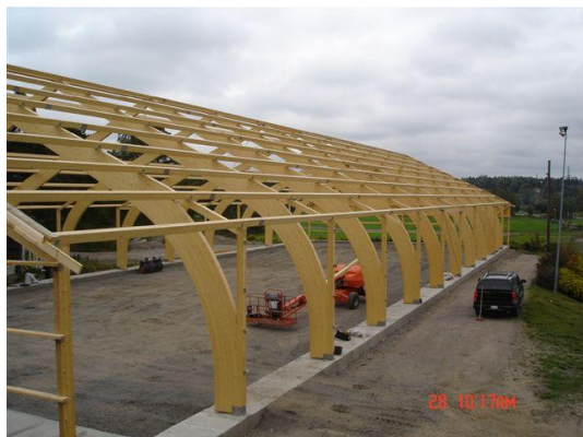
Bild 2.1 Takkonstruktion med takås, se Bygg i limträ (2012).
