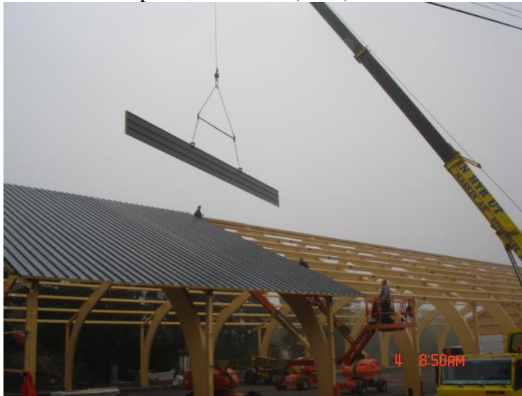
Bild 3.4.1 Montering av sandwichelement på limträstomme, se Bygg i limträ (2012).
