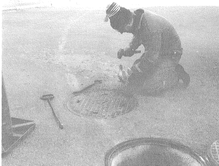
Fig. 2.21 Vissa typer av brunnslock kan bjuda hårt motstånd. Här är förhållandena extra besvärliga till följd av minusgrader.
