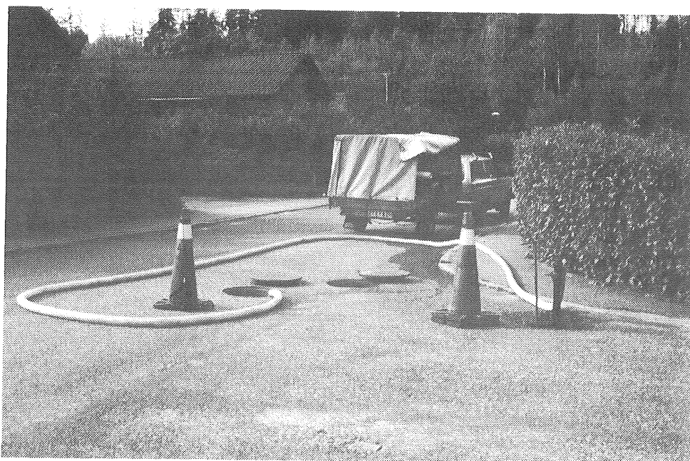
Fig. 2.13 Brandslangar leder vattnet från brandposten till dagvattenbrunnen.
