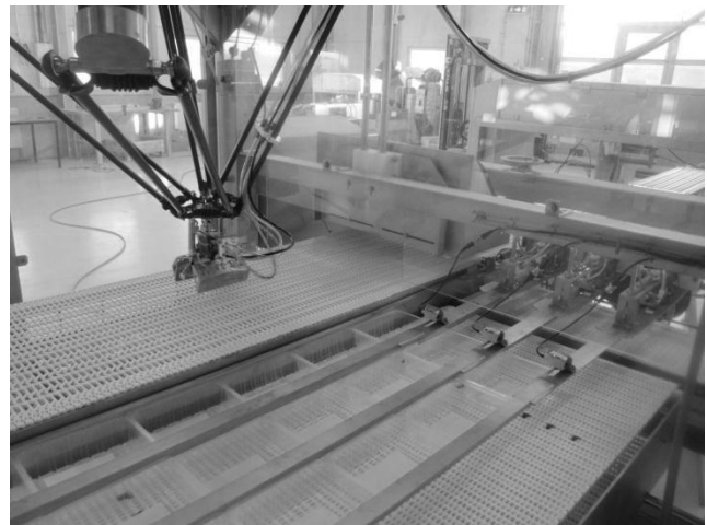
Figur 2.1: Paketeringsmaskin sedd inifrån robotburen.
