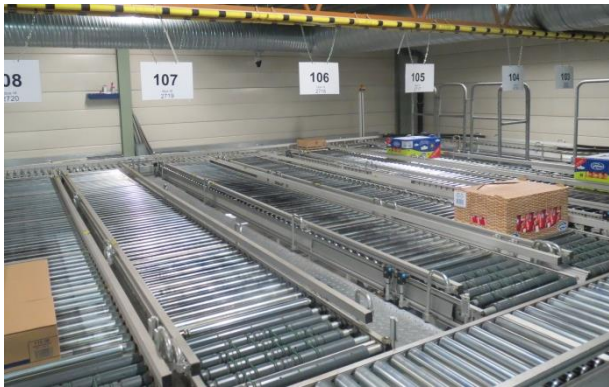
Figur 2.3 Buffertbanor på pallerteringsstationen.
