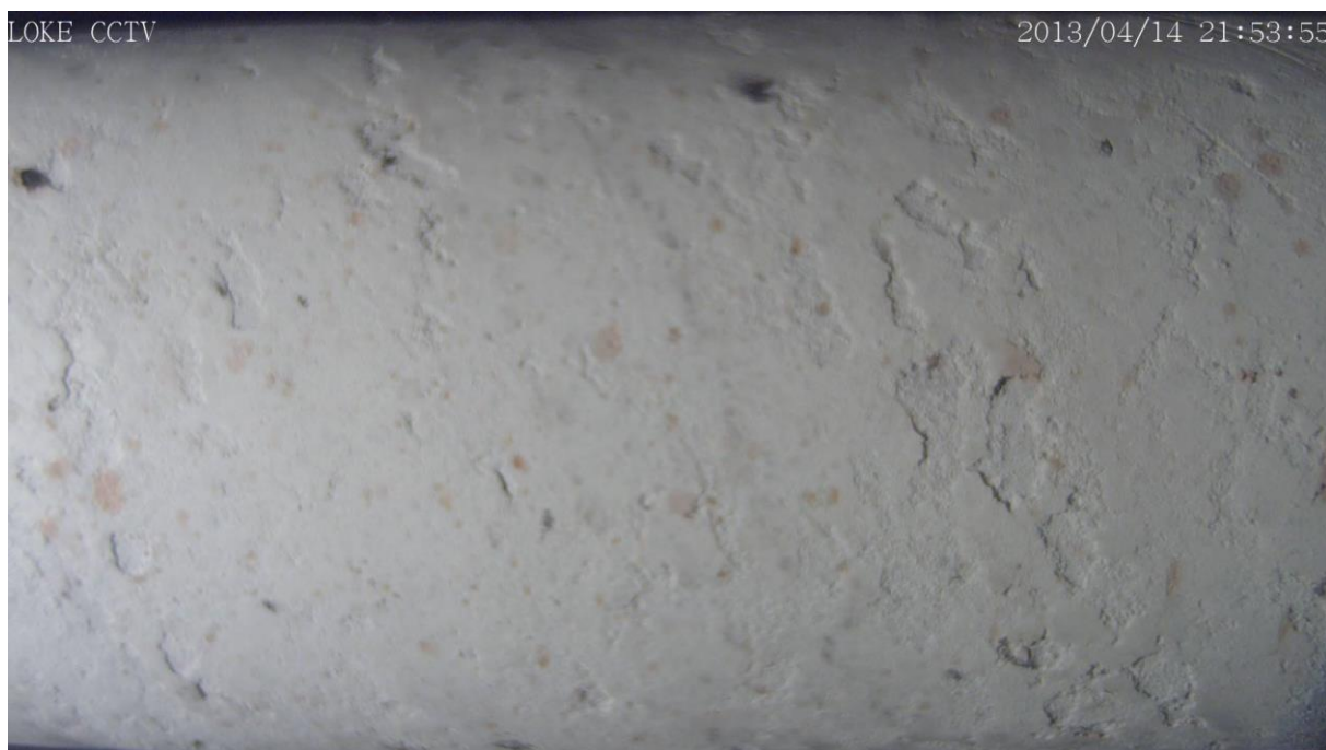
Figur 4.1: lans med rödaktiga fläckar
