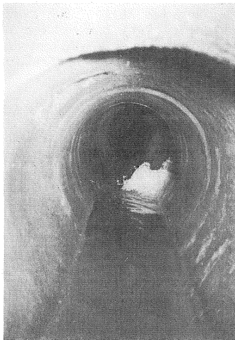
Figur 2.16 Inläckage till kombinerad ledning H750, Norra Hamngatan.
