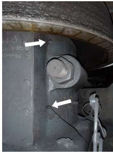
Figur 4.9. Bild på stödhjulet i KK3 med pilar som pekar ut placeringen av två temperaturgivare.
