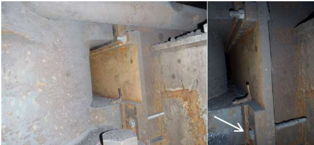
Figur 4.18. Två närbilder på stödhjulets lagerhus och fundamentet mellan stödhjulen. Den vita pilen visar chimsen, plåtbitarna som kilas in mellan lagerhus och fundament för att tillsammans med stängerna begränsa spelet mellan stödhjulen. Ett av chimsen har lossnat till följd av de stora krafterna mot stödhjulet.
