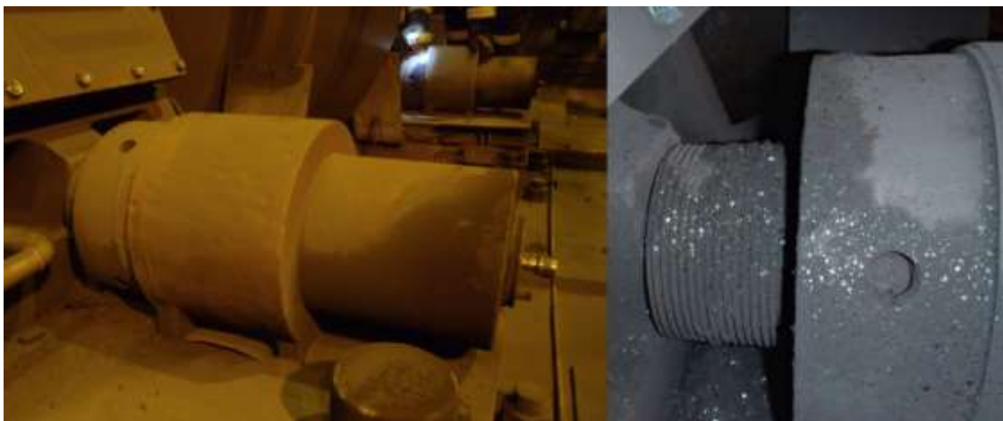
Figur 2.9. En bild på domkraft kopplad till bärhjulets lagerbock och en närbild på dess gängor.
