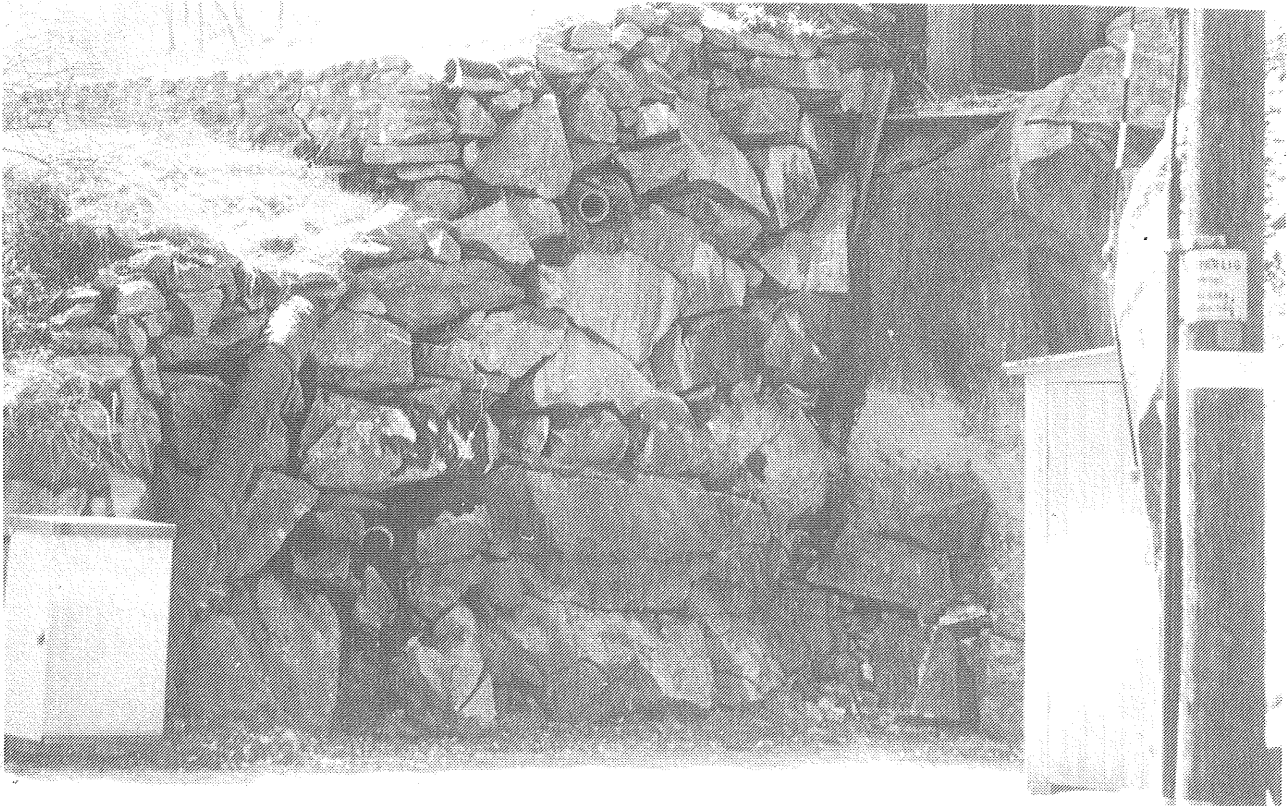
Figur 14. Udda lösningar av dräneringen har ibland måst tillgripas. Här mynnar dräneringsledningarna på två nivåer i stensättningen. En isolerad ledning har dragits utanpå muren.
