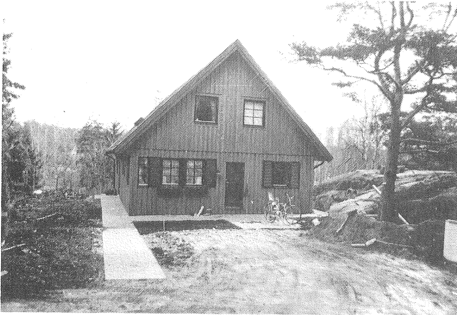
Figur 4. Nybygge vid Östfjällsvägen.
