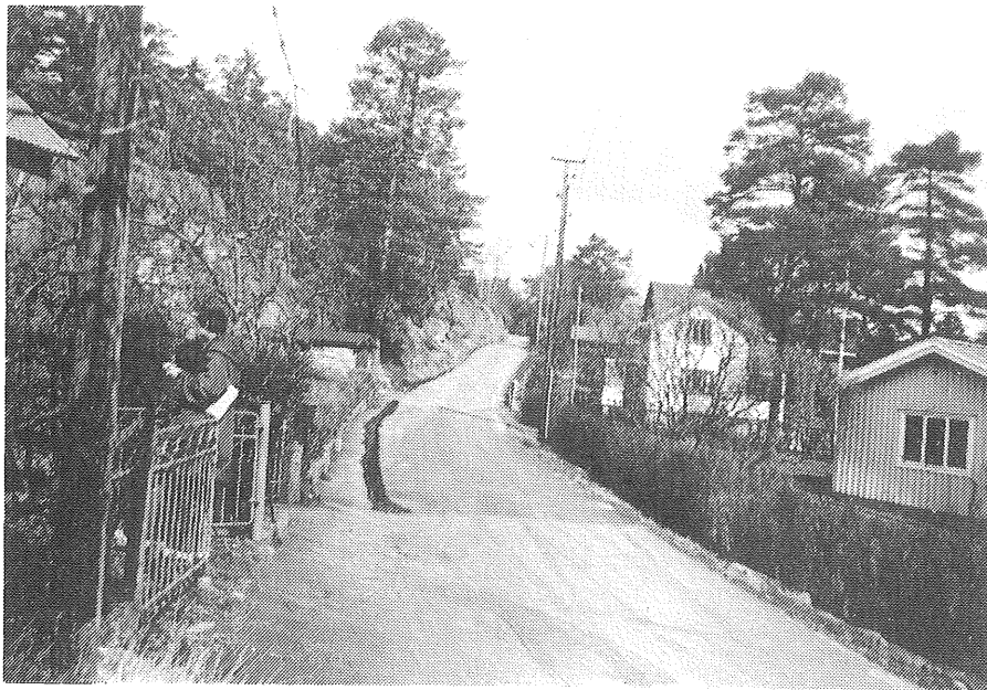
Figur 6. Östfjällsvägen mot norr. Exempel på gata med låg standard. Observera dagvattenavledningen.
