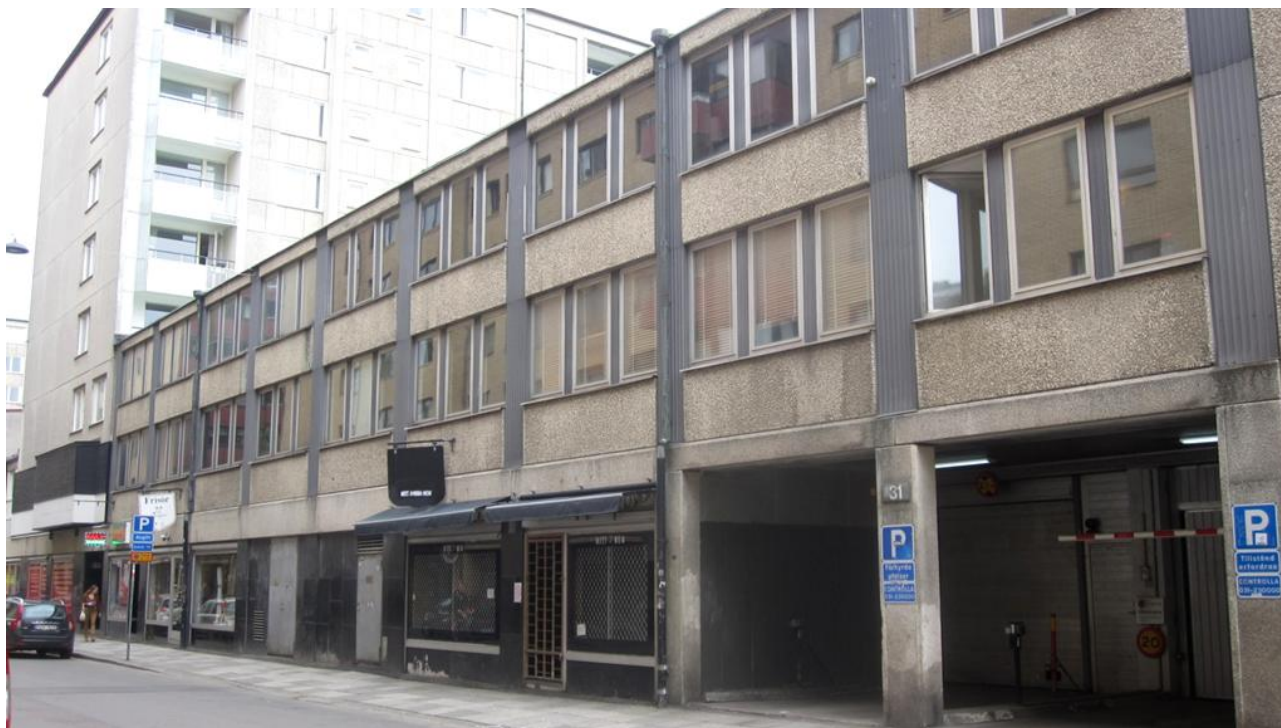
Figur 16. Fasaden på Hus C mot Andra Långgatan.
