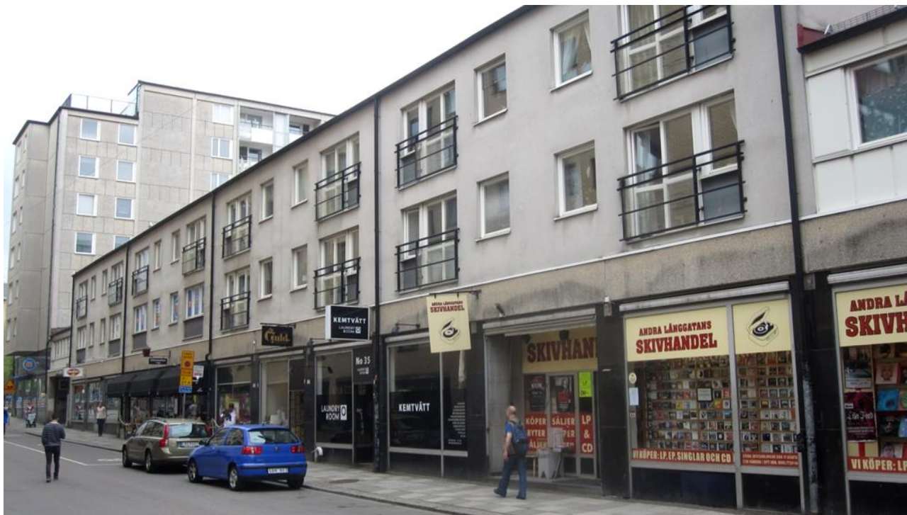
Figur 18. Fasaden på Hus F mot Andra Långgatan.
