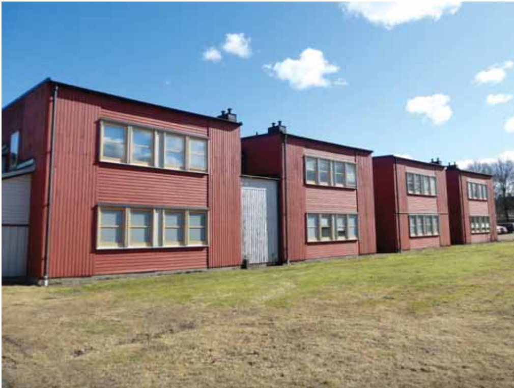
Hus B, fasad mot väst.
