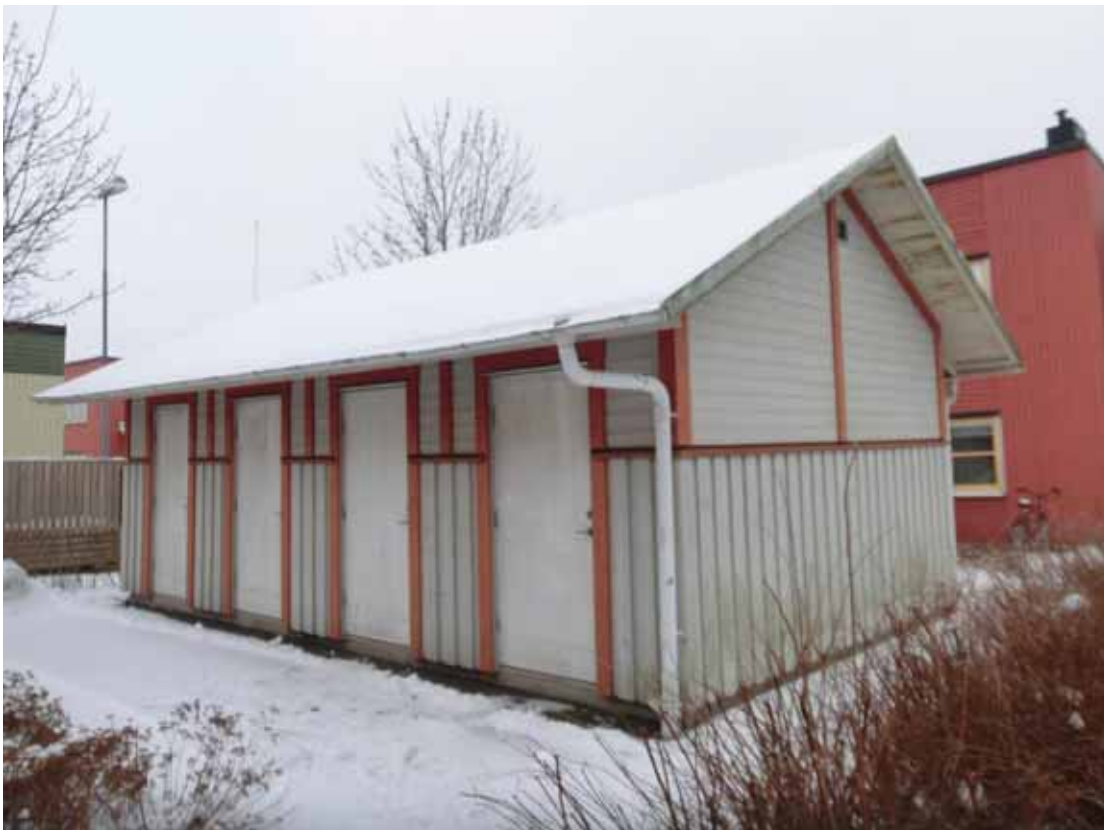
Hus G med lägenhetsförråd.
