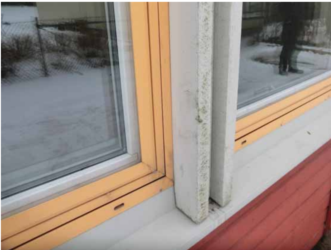
Samtliga fönster är försedda med ett yttre glas för att minska energiförluster.
