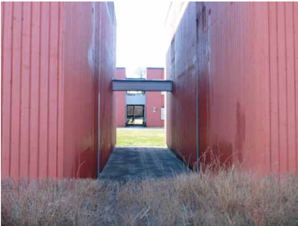
Obebyggd yta mellan två huskroppar som tillhör hus B. Innan ombyggnaden år 1991 fanns ett trapphus här likt tidigare bild, vilket syns på fasaderna.
