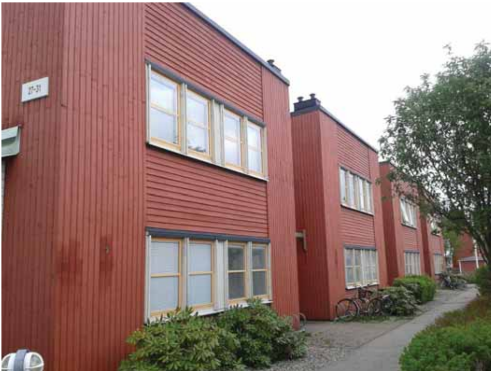
Hus B, fasad med entréer mot öst.
