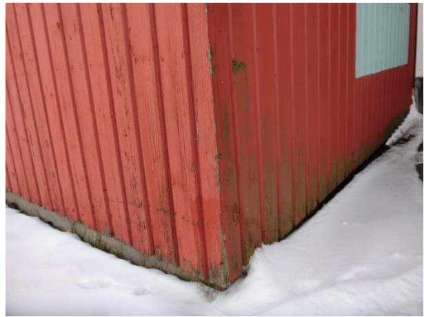
Figur 4.8: Fasad hus A. Ändrätet har börjat ruttna.
