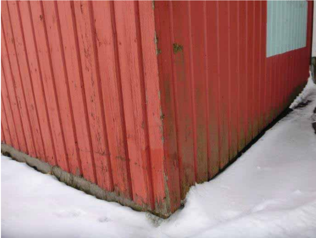
Grön växtlighet på fasadplankor.
