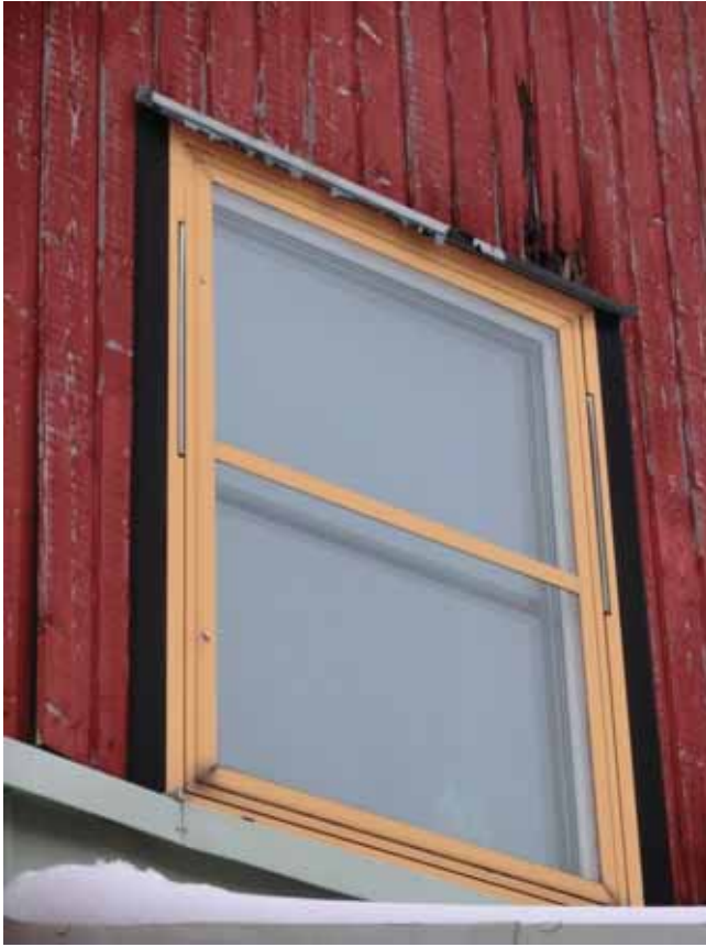
Rutten fasad vid fönster på hus C.
