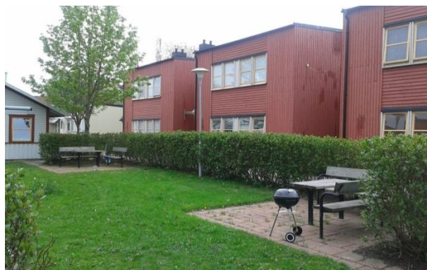
Figur 4.17: Uteplats belägen mellan hus B och hus D. Utemöbler finns till förfogande för de boende.
