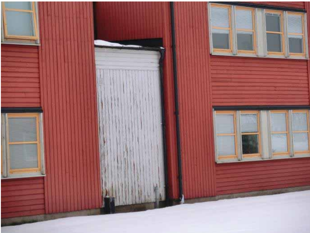
Baksidan på hus C. Här syns det inbyggda trapphuset med teknikrum.
