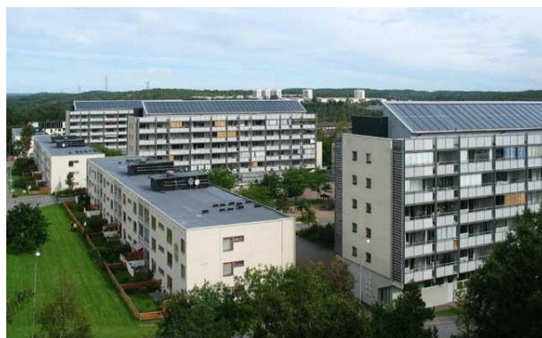
Figur 2.3: Vy över de renoverade solhusen i Gårdsten. Här ses även de nya solfångarelementen placerade på loftgångshusens tak. (CNA, 2013)
