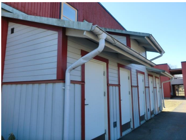
Figur 4.14: Hus D, utvändiga förråd.
