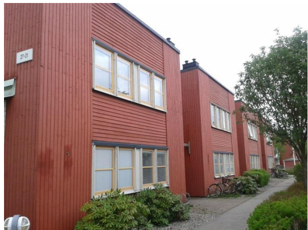
Figur 4.11: Framsida hus B. Här syns entréerna samt byggnadernas fönster som ofta är fördragna med persienner.
