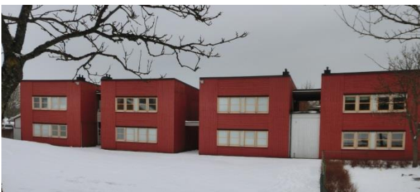
Figur 3.7: Hus D, baksida mot öst.
