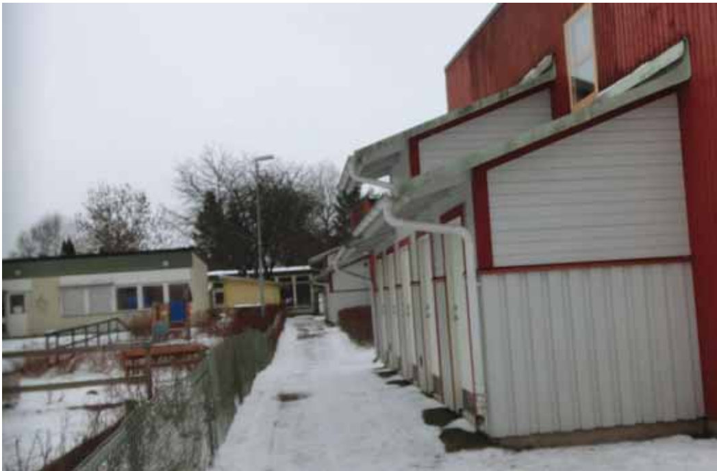
Hus D, fasad mot norr är försedd med lägenhetsförråd som angränsar mot förskolans tomt.
