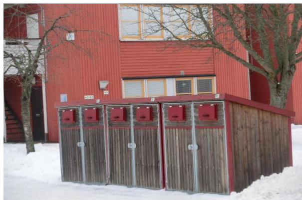
Figur 4.20: Soppantering, södra parkeringen.
