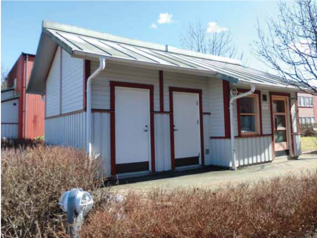
Hus F med förråd och tvättstuga i en färgglad kulör som matchar bostadshusen.
