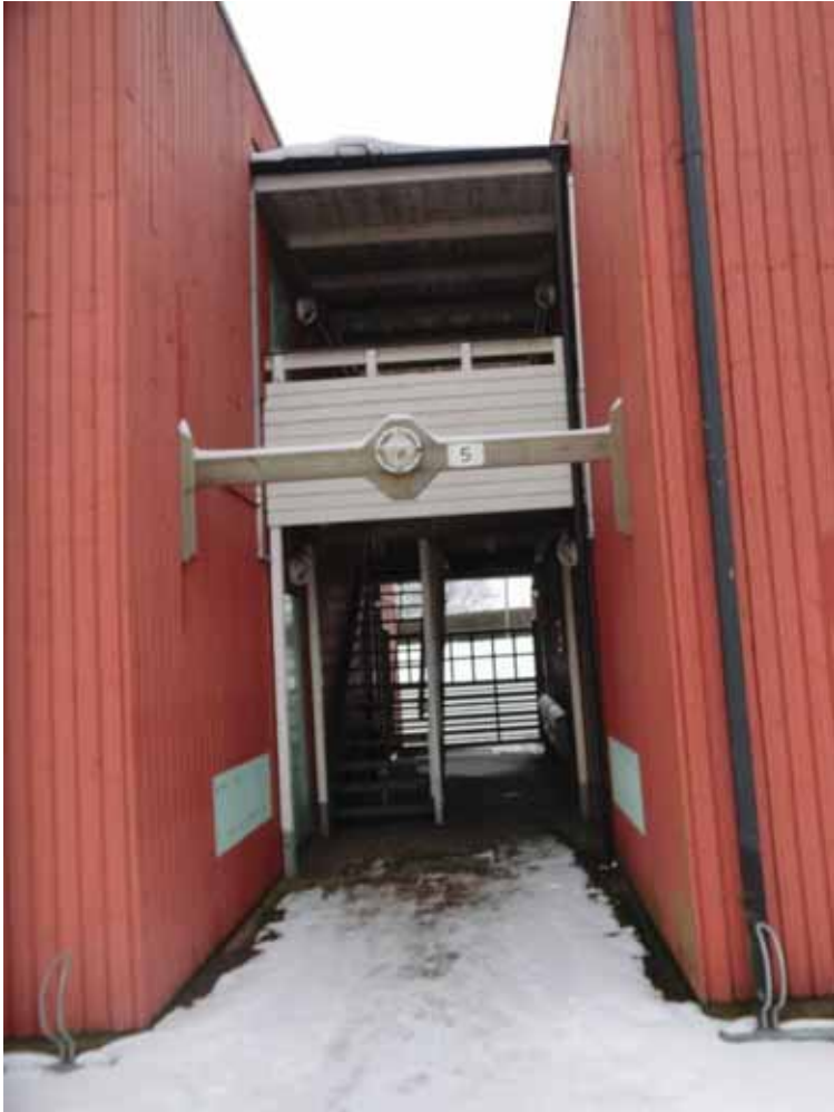
Hus D, öppet trapphus.
