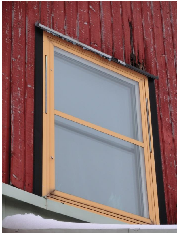
Figur 4.9: Rutten fasad vid fönster på hus C.
