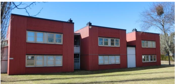
Figur 3.8: Hus E, baksida mot öst.
