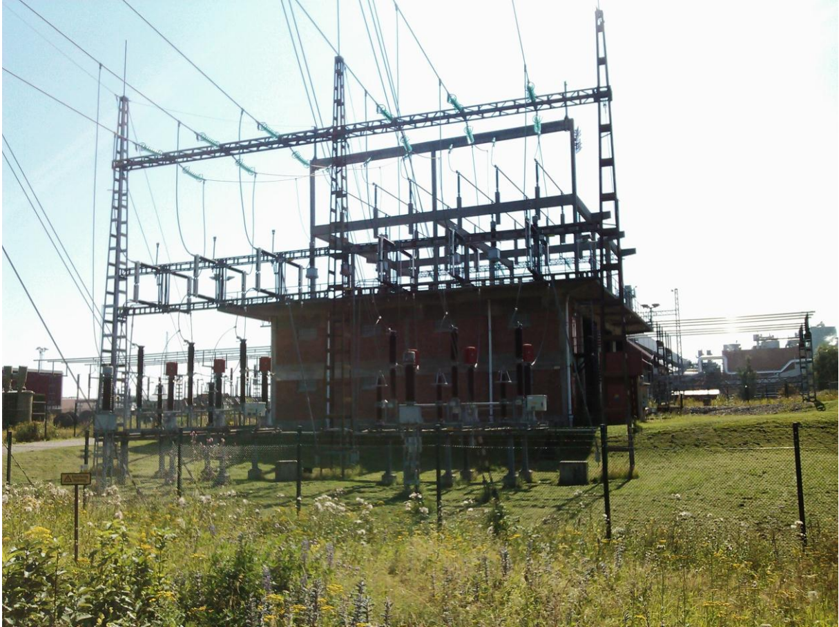
Figur 8: Inkommande huvudställverk – ORT145
