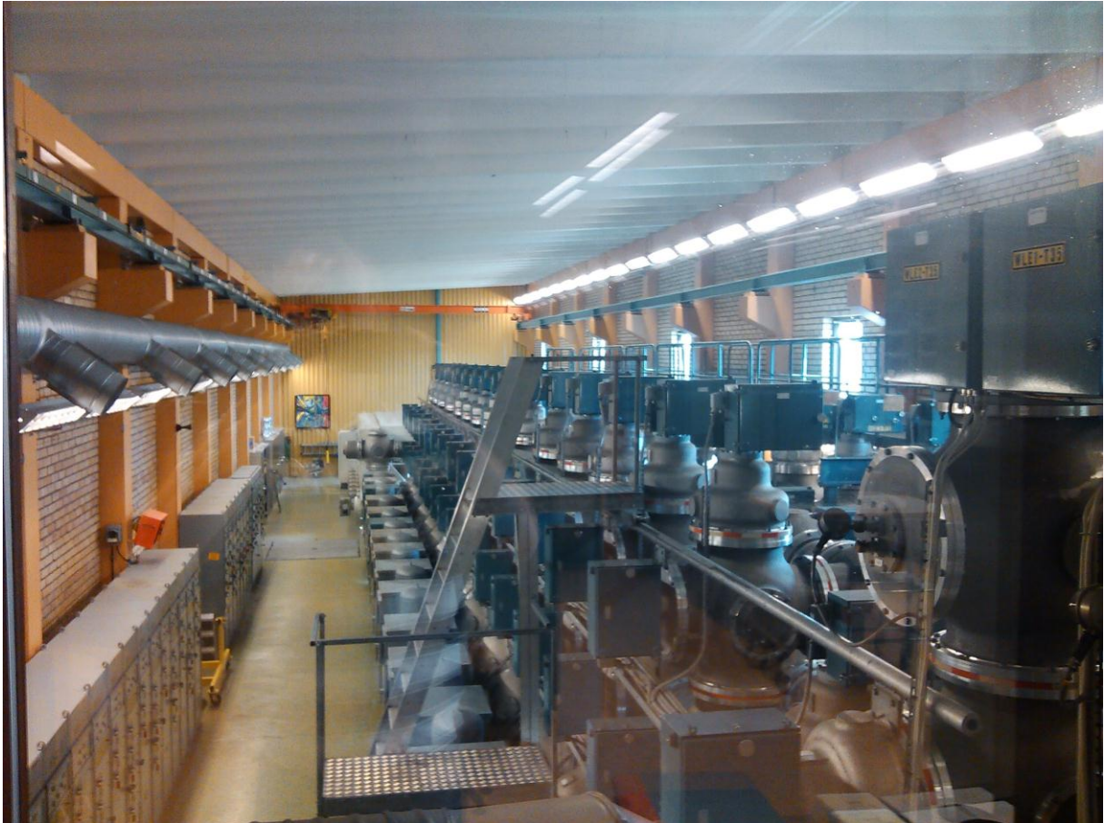
Figur 9: Gasisolerat ställverk (GIS)
