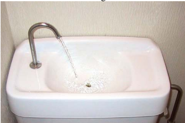
Figur 30. Exempel på handfat byggd på cistern som samlar vatten för toalettspolningar.
