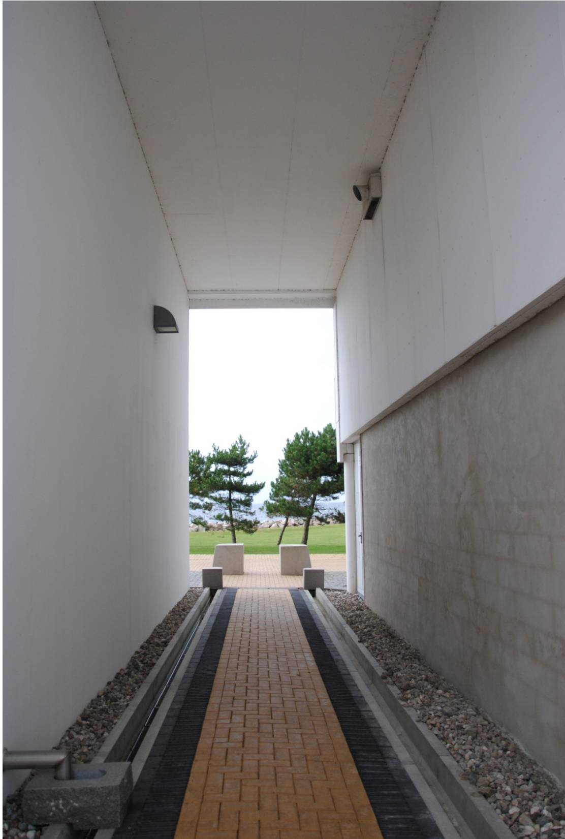
Figur 12. Gångvägen med dagvattenrännorna leder ut mot havet och strandpromenaden som är populärt hos malmöborna.
