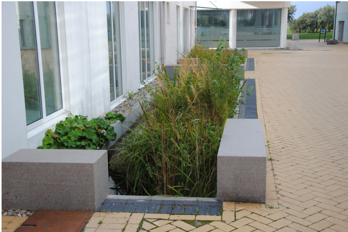
Figur 8. Synlig dagvattenhantering med plantering.
