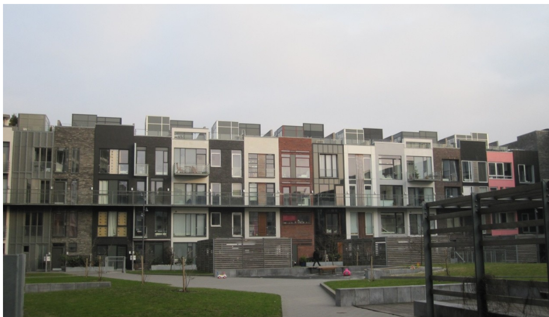
Figur 21. Byggnad sedd från innergården, Sluseholmen.
