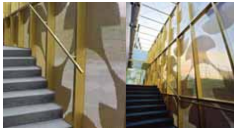
Variert genomskiktighet genom perforerad aluminium sett från insidan, Maison de Portugal, Paris.
