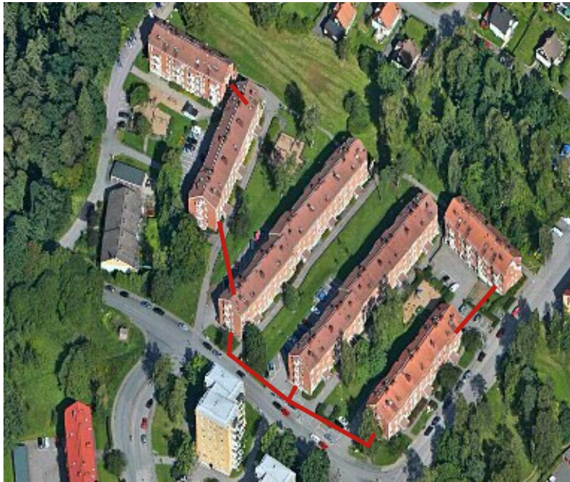
Figur 3: Illustrativ bild av framledningsnät av fjärrvärme vid HSB Honungsskivlingen (Eniro, 2012)
