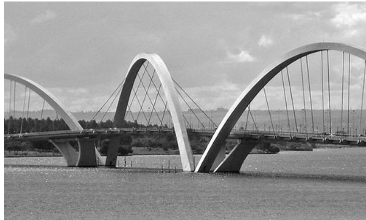
Juscelino Kubitschek bron i Brasilien, 2002 av Alexandre Chan och Mário Vila Verde. En bågbro med flera spann och tvärsållade bågar.
