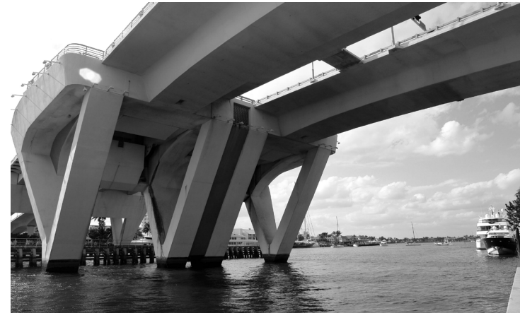
17th Street Causeway Bridge i Florida, USA, 2001 med ett triangulärt stöd, en så kallad Carina Pier, vid klaffen.
