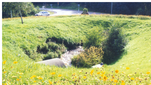
Figur 4.3: Kulvertering inne i rondellen
