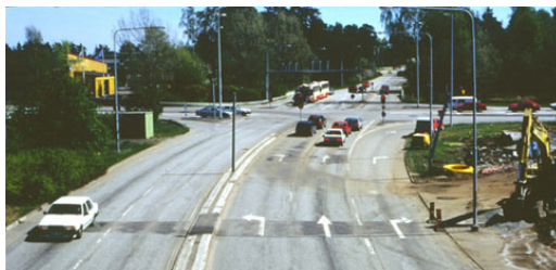
Figur 4.19: Gärdhems-krysset innan ombyggnad. (Källa: Vägverket, 2001)
