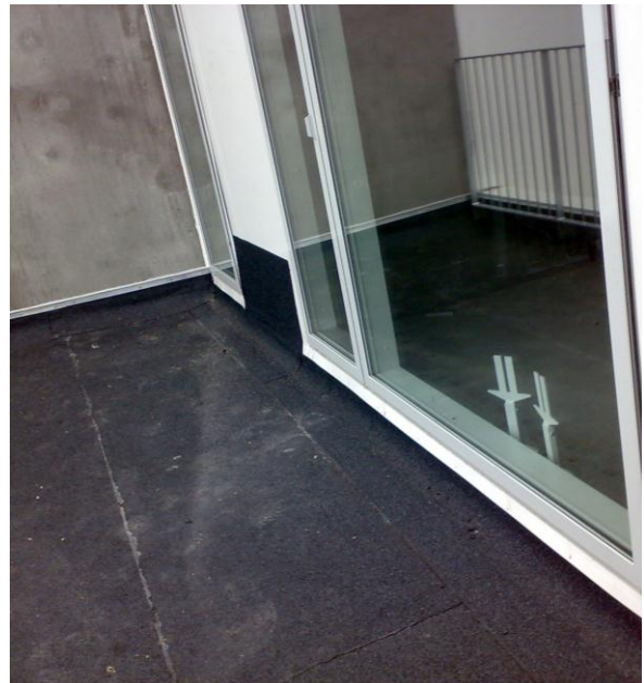
Billede 8: Tagterrace med tagpap, Paroc og vinduer [6. august 2008].
