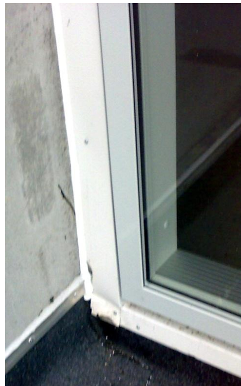
Billede 16: Fuge mellem Paroc-element og trappetårn [6. august 2008].
