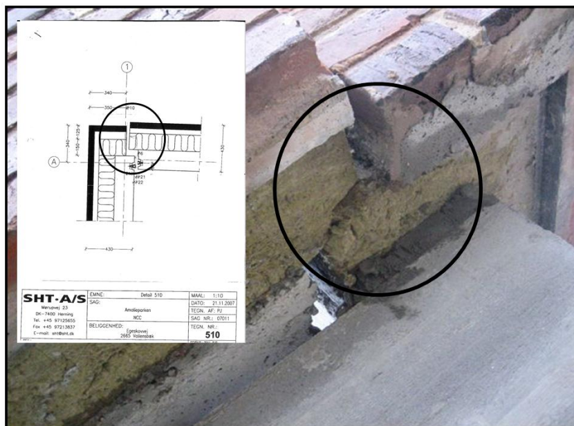
Billede 1: For meget isolering [formandens foto / NCC intern årsagsudredning]
