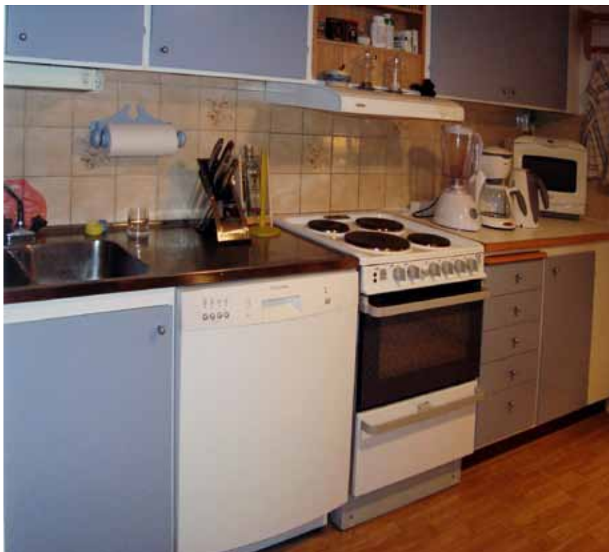
Köket som de boende upplevde som dåligt planerat med diskbänk i hörn mot kyl- och frys-skåp, samt alltför kort avstånd mellan spis och diskho.
