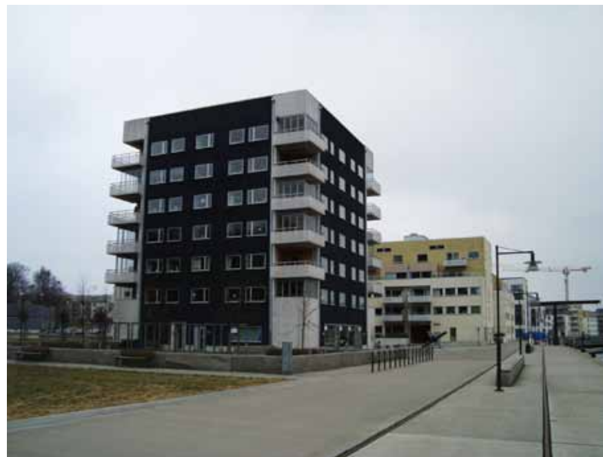
Den undersökta lägenheten ligger i ett sju våningar högt punkthus längst ut på kajen vid Sannegårdshamnen. Här var tidigare stora kolupplag.
