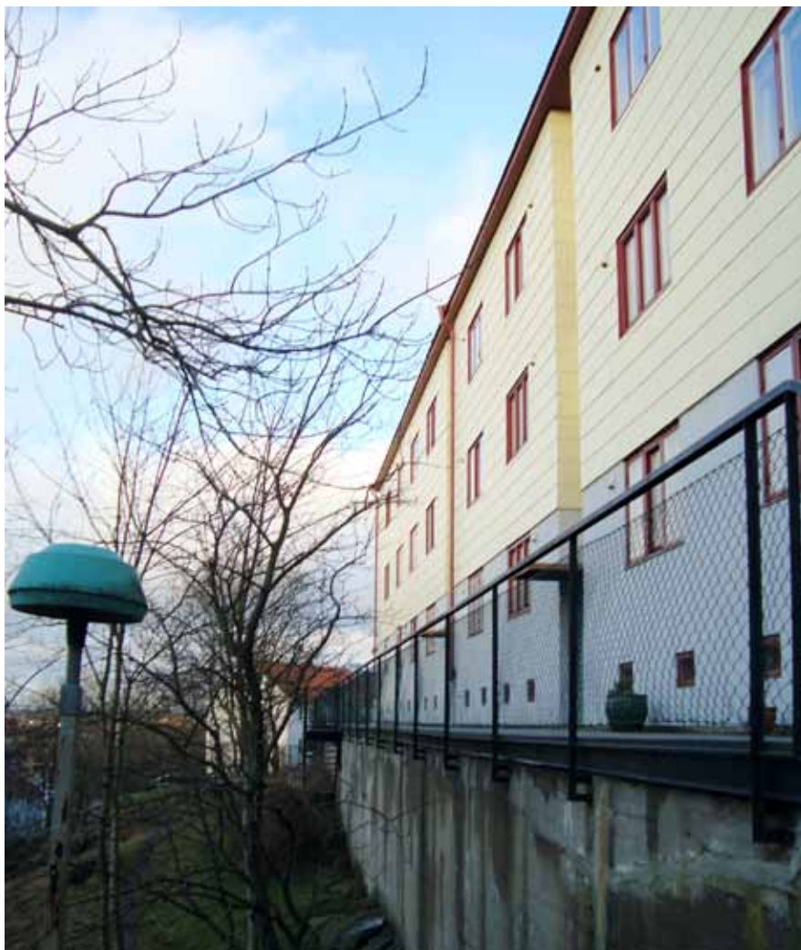
Kvarterets utsida, stora nivåskillnader har tagits upp av en hög sockelmur. Entré sker från en entrébrygga på konsoler.
