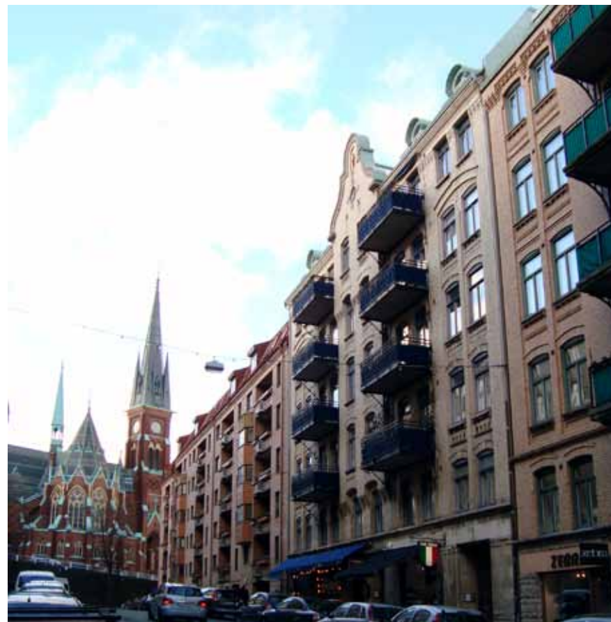
Bostadshuset ligger i Göteborgs stenstad.
