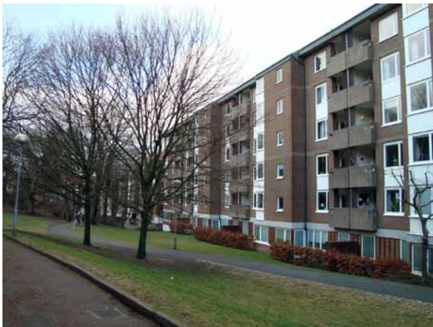
Lägenheten vetter ut mot en park och då den är enkelsidig har den ingen kontakt med gården.
