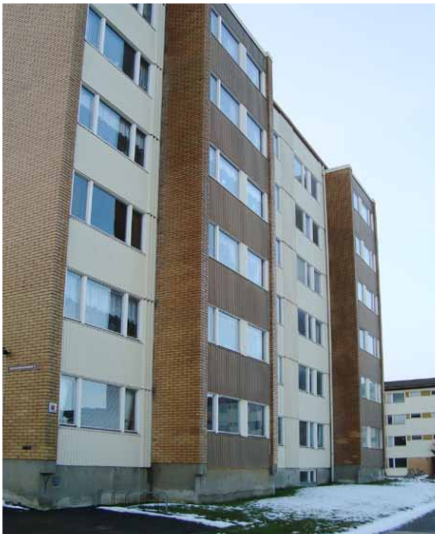
Fasad mot gården. Huset möter marken med en hög betongsockel.
