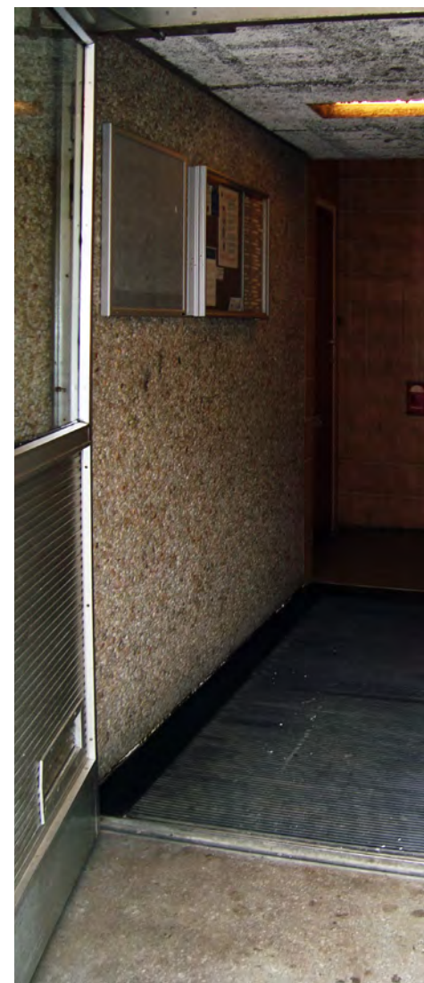
Entréerna med aluminumdörrar och invändig fasad med sjösten.
