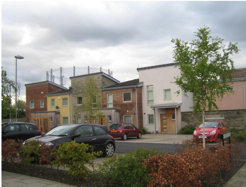
Figur 10: Förhållandet mellan gaturummet och bostadshusen i Staiths South Bank.
