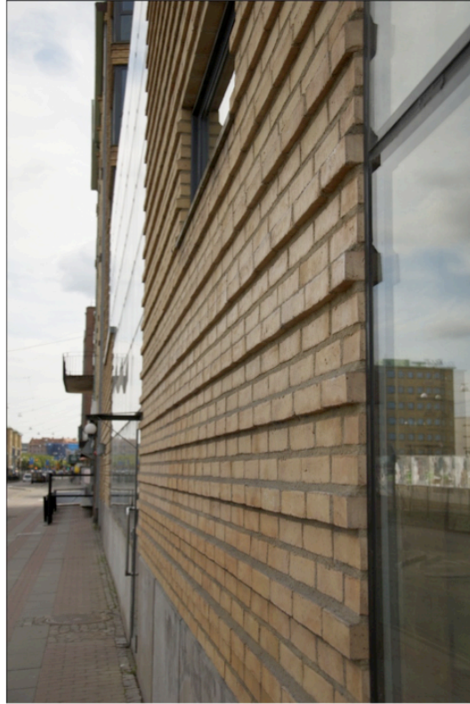
Figur 19: Ljudspridande fasad vid Masthugget
