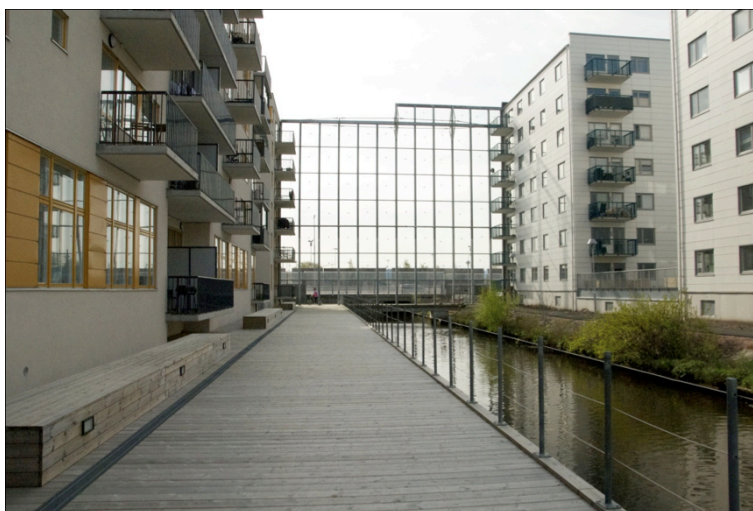
Figur 17: Glasväggar mellan lamellhus vid porslinsfabriken i Göteborg sett från insidan
