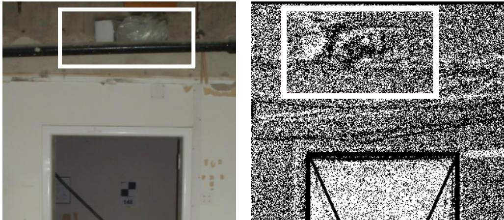
Figur 24 och 25: Den vänstra bilden (von Feilitzen, Klarqvist, 2009) visar ett foto där det framgår att håltagningen är igensatt, den högra bilden visar hur detta framkommer något otydligt i punktmolnet.
