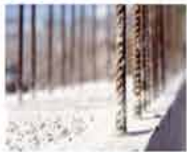
CONCRETE (Skanska AB betongfabrik)
