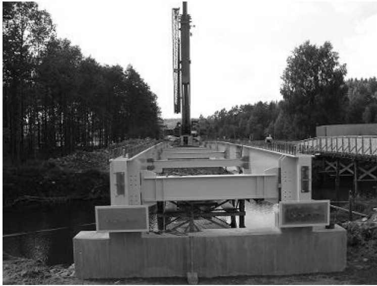
Figur 6.2 - Stålbalkarnas uppbyggnad för en samverkansbro. (sbi.se)
