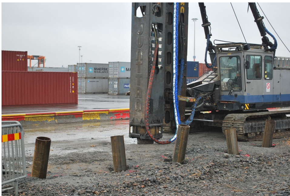
Figur 4 - Visar maskinen som användes vid stålörspålningen och slagna bottenrör
