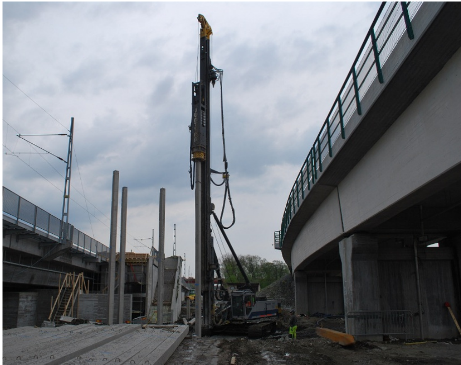
Figur 12 - Arbetsplatsens arbetsområde och upplagsplatsen för pålar
