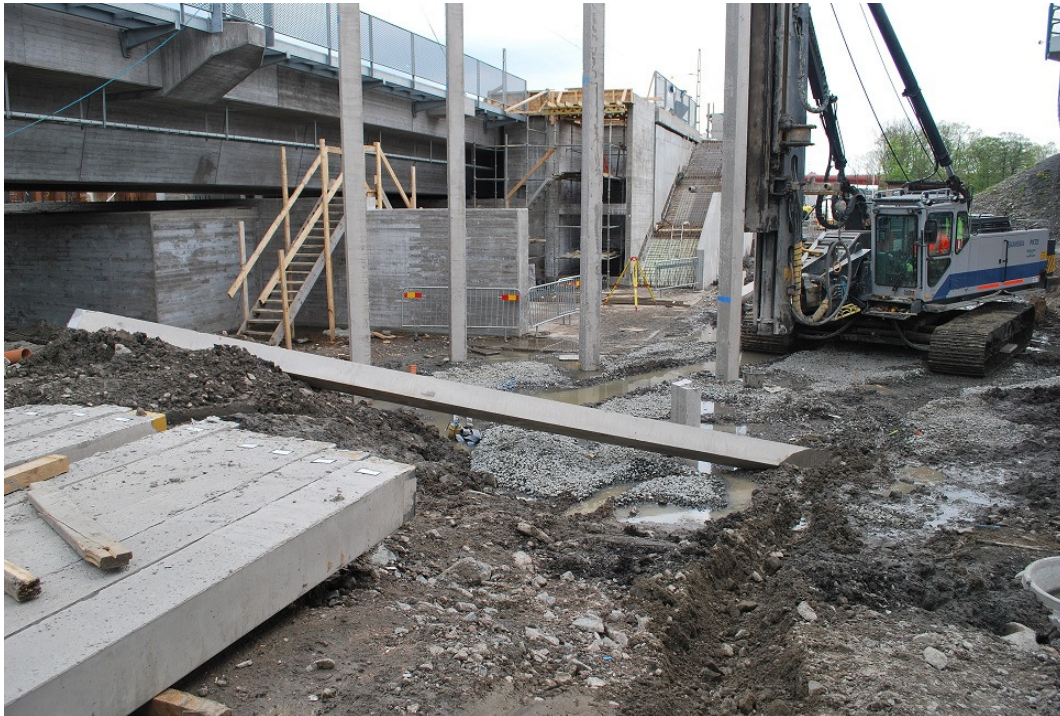
Figur 5 - Visar maskinen som användes vid betongpålningen, slagna betongpålar och man ser tydligt hur begränsad arbetsytan är.
