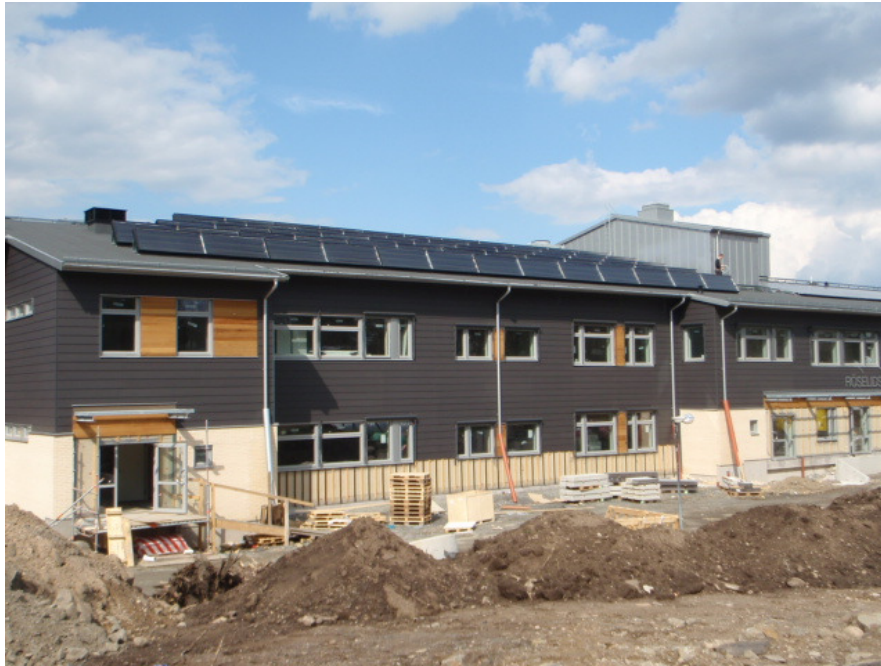
Figur 10: Roselidsskolan under byggnationen
