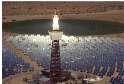
(d) Solar tower plant.
