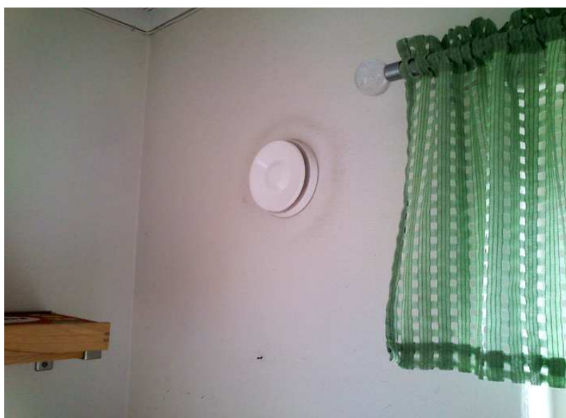
Figur 3.1 Friskluftventil monterad i fasaden på Hammerö förskola.
