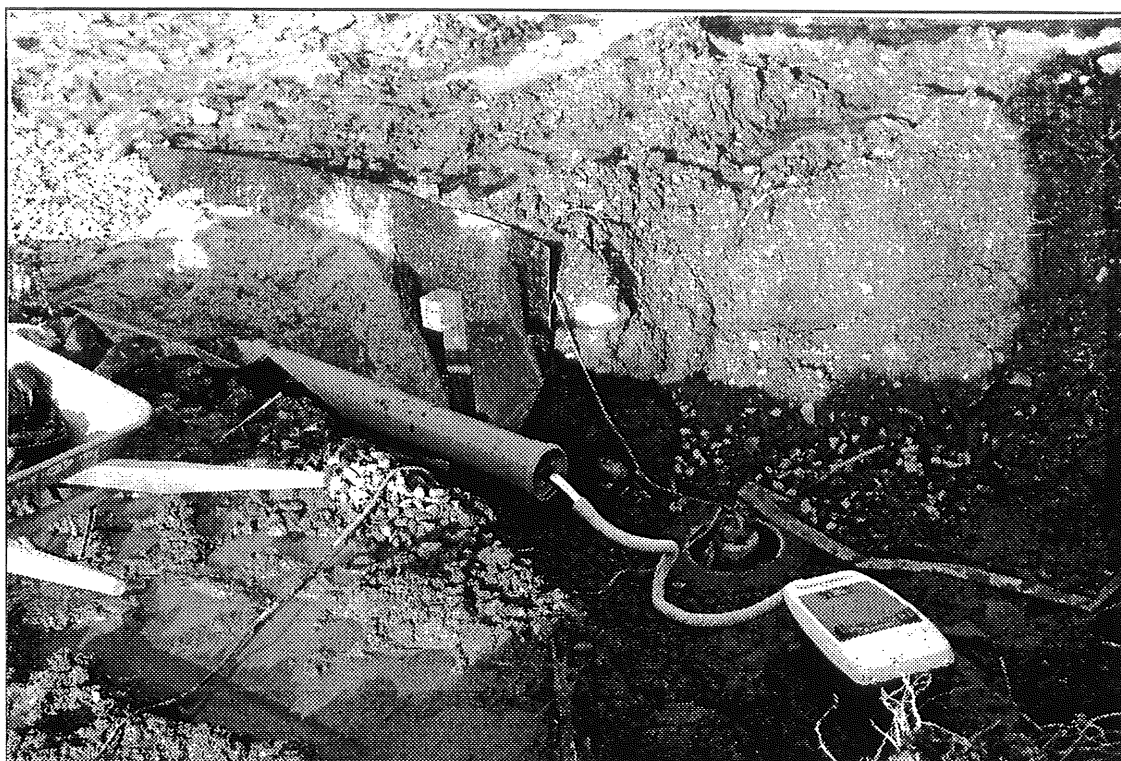
Figur 2.6 Röret för gasprovtagning under strängkomposten sticker ut från makadambädden i en provtagningsgrop. Här med dammsugaren ansluten.
