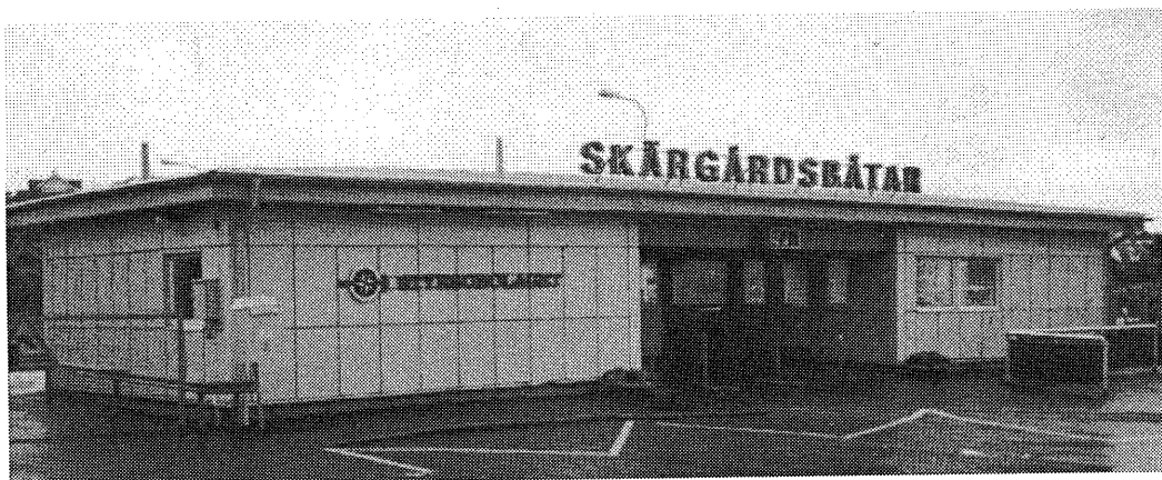
Bild 10: Terminalbyggnaden för skärgårdstrafiken vid Saltholmen
