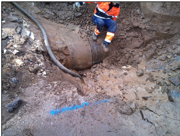
Figur 43. Bild på schaktgropen. Betongröret som syns är en dagvattenledning. Foto: Johan Emanuelsson
