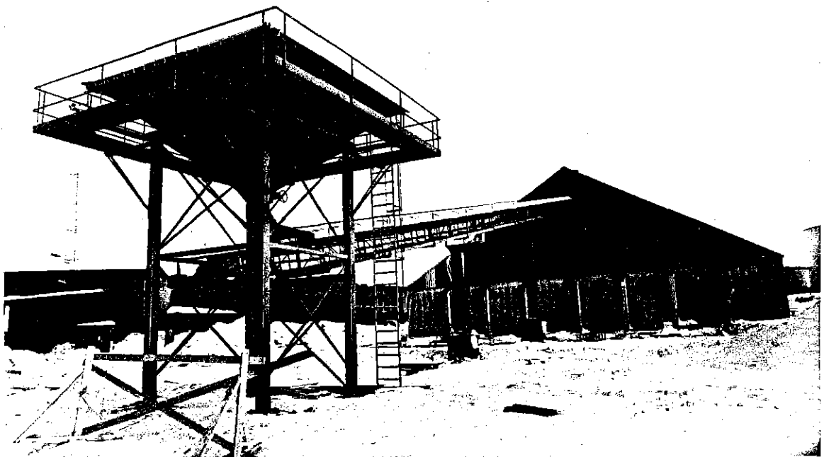
Figur Transportband från kaj till magasin. Kapacitet 300 ton/tim.
