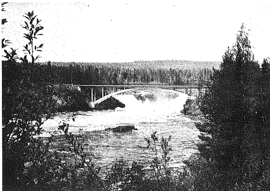
Bild 10. Jockfallet, 50 km uppströms Överkalix, utgör ett svårt vandringshinder för lax. Fallhöjd 9 m.
