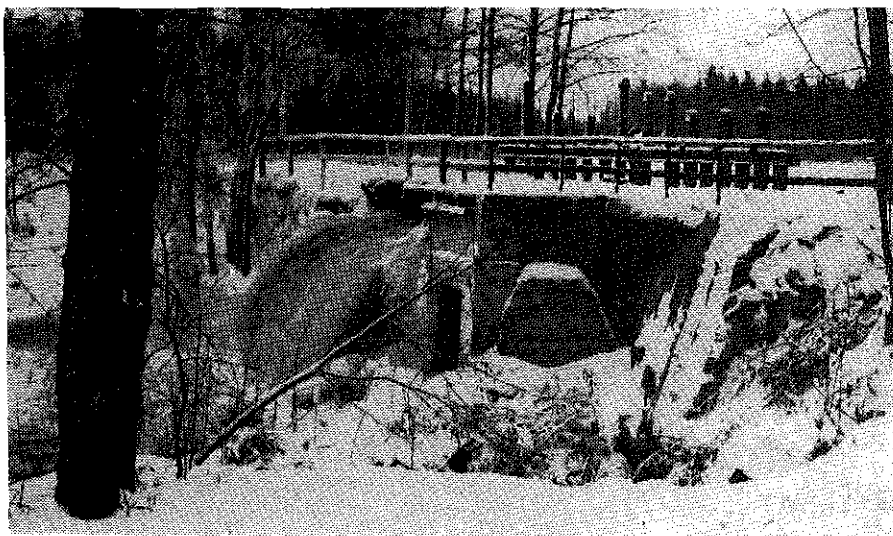
Fig. 33 Valsverket - Dammen med det igenmurade tubintaget.
