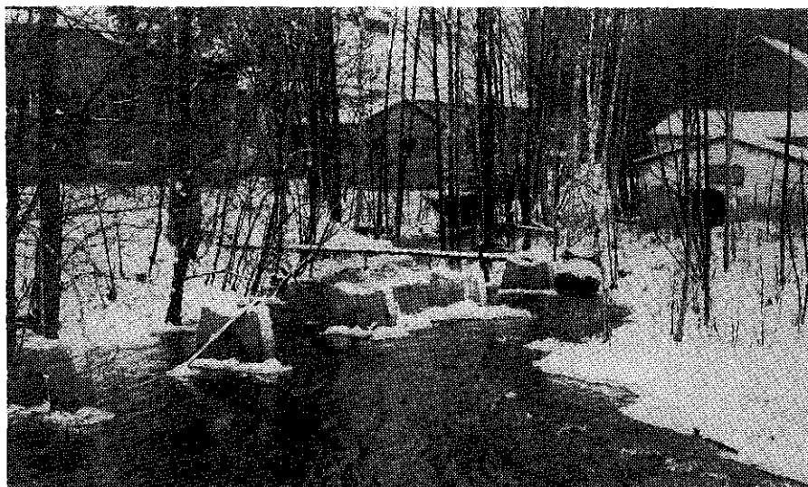
Fig. 34 Valsverket - Tubfundament. Till höger kraftstationsbyggnaden.
