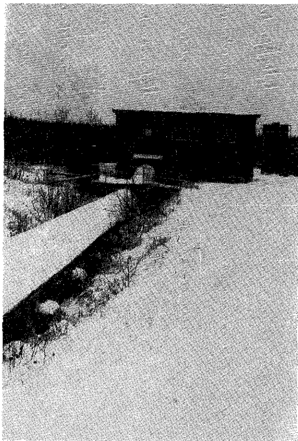
Fig. 6 Svartå bruk-Tilloppstub I bakgrunden kraftsta- tionen
