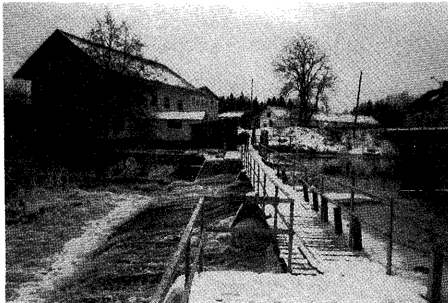
Fig. 19 Hidinge bro - Damm sedd från norr
