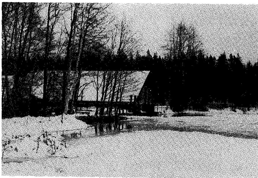
Fig. 36 OXHULT - Damm och kraftstation
