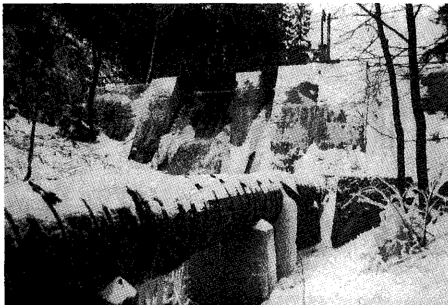
Fig. 38 Garphyttan - Damm med tubintag
