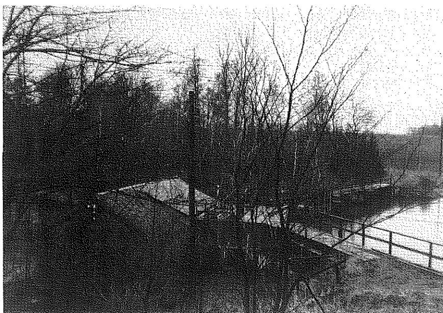
Foto 18 Blombacka kraftverk. Fallhöjd 2,4 m. Effekt 60 kW
