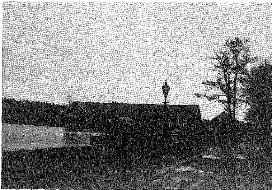
Foto 19 Bränningebergs kraftverk: Kraftverksdammen.
