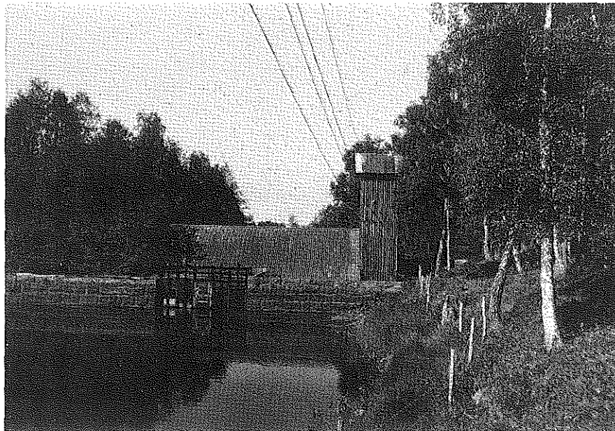
Foto 4 Kvissle kraftverk. Maximal effekt 200 kW.
