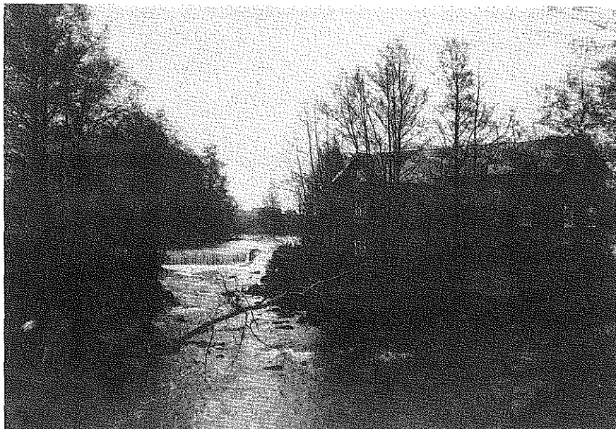
Foto 23 Stockens kvarn med överfallsdamm. Fallhöjd ca 2 m
