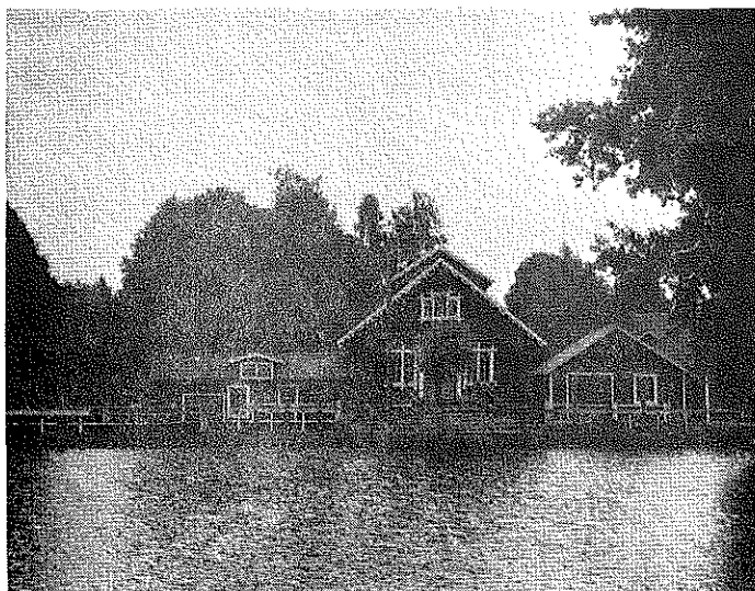
Bild 3 Kvarn och kraftstation vid Hällinge gård
