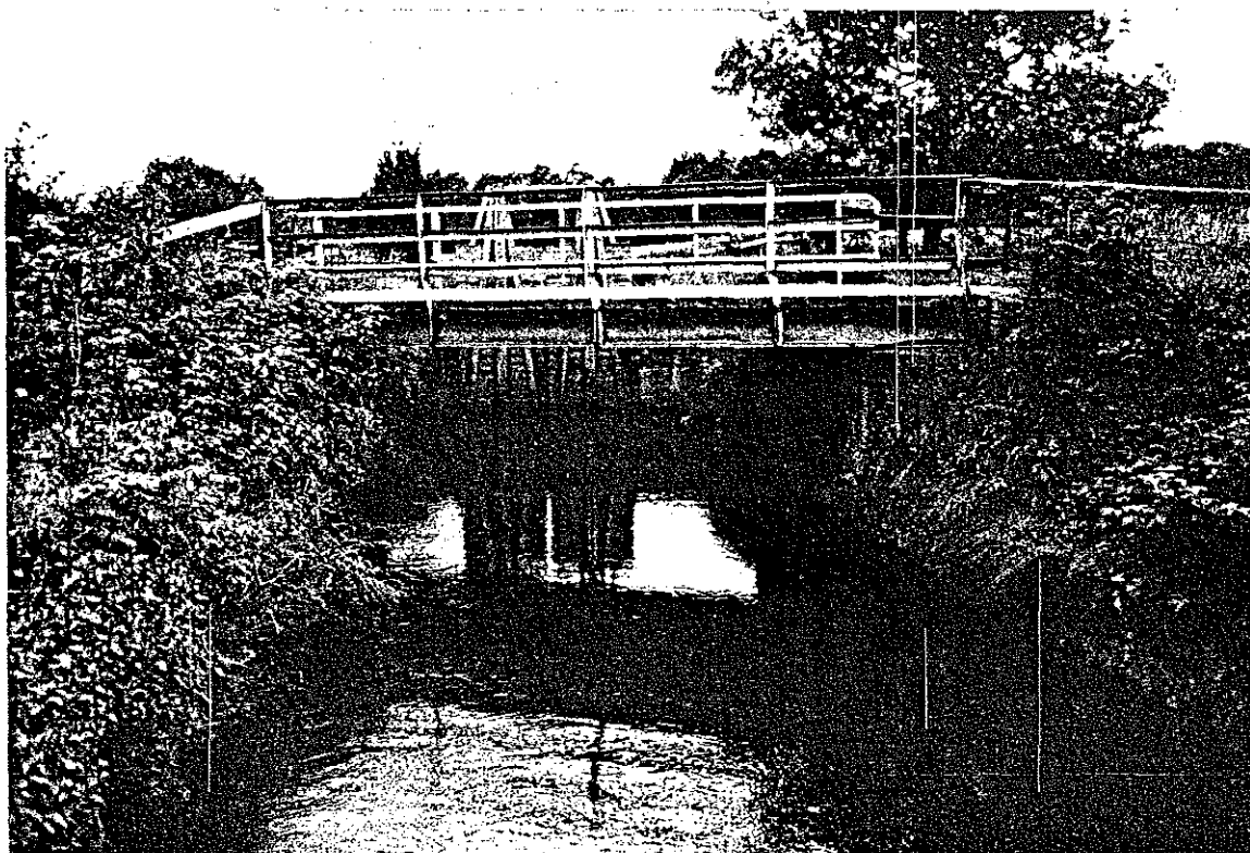
Kanalintag med bilbro och spetttluckor
