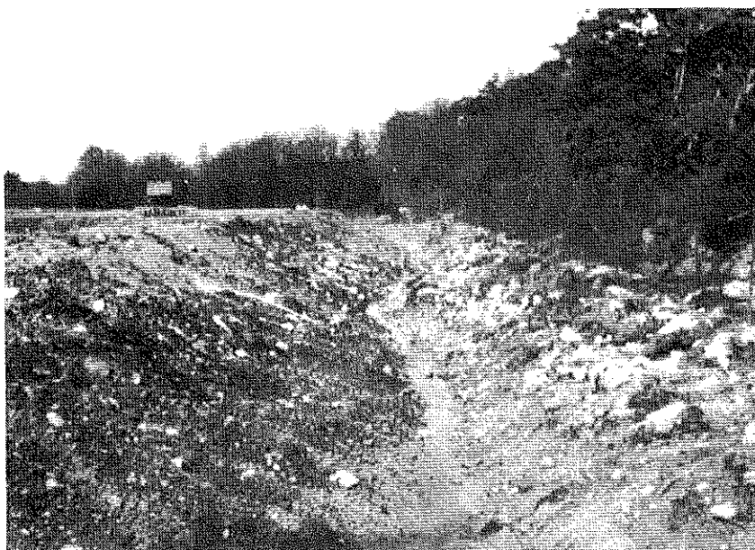
Foto 9.4. Ytvattendike runt slaminvallningen.
