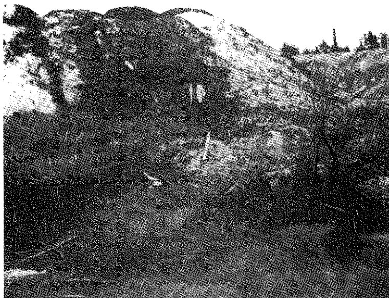
Foto 13.2. Sågverksavfallet tippas i pallar med en tjocklek på upp till ca 5m.
